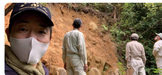
長崎市現川駅周辺の集中豪雨による地すべり災害対応
